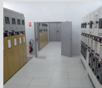
Poste "Nord" - Vue de l'intérieur
