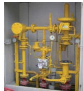
Poste livraison client
