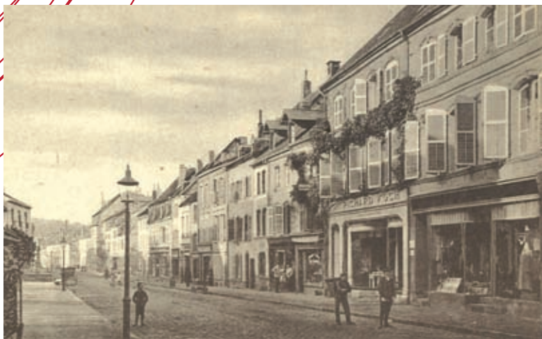
Rue du Général Hirschauer - Eclairage public au gaz
