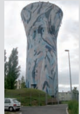
Château d'eau de la Carrière
