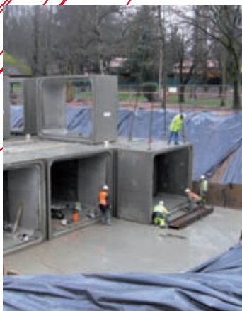
Construction d'un bassin d'orage rue Joffre (Au parc municipal)
