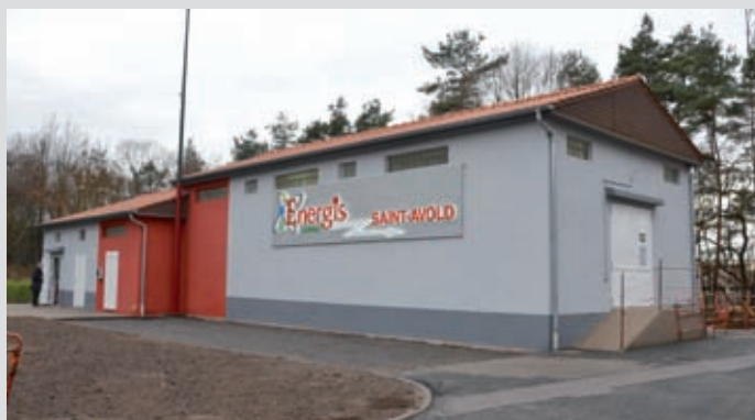
Poste de répartition 20 kvolt "Nord"
