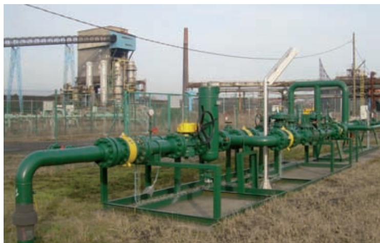
Poste principal sur réseau
