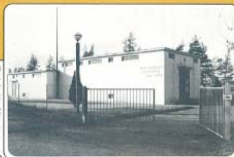
▲ Poste de livraison
