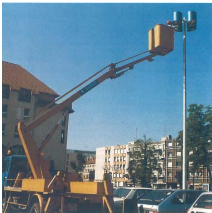
◀ Entretien d'un luminaire d'éclairage public
