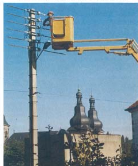
Travaux sous tension sur réseau basse tension ▼
